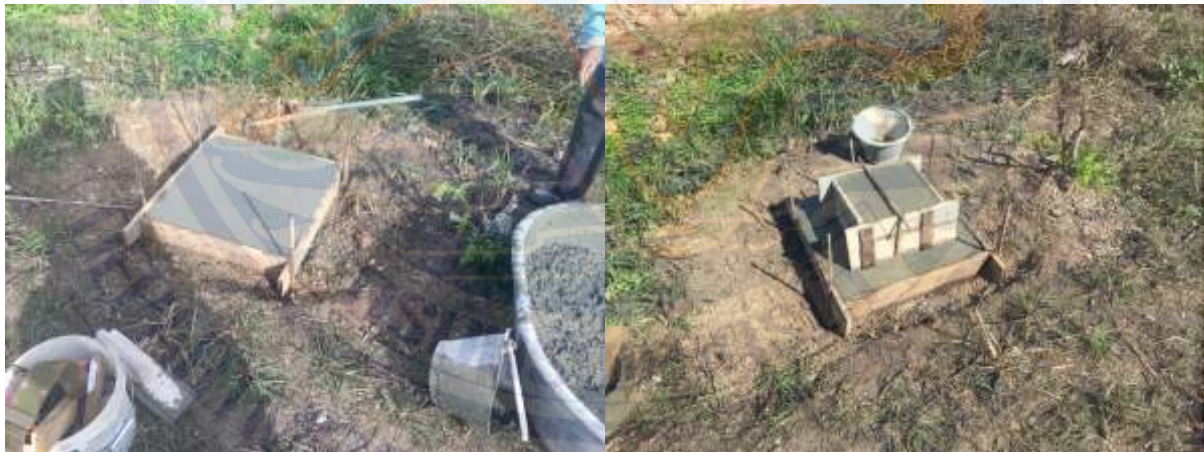
รูปที่ 2-4 การหล่อคอนกรีตให้เป็นรูปทรงสี่เหลี่ยมจัตุรัส
