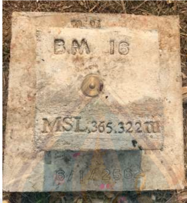
รูปที่ 2-5 หมุดหลักฐานถาวรแบบ ก. ที่ก่อสร้างเสร็จแล้ว
