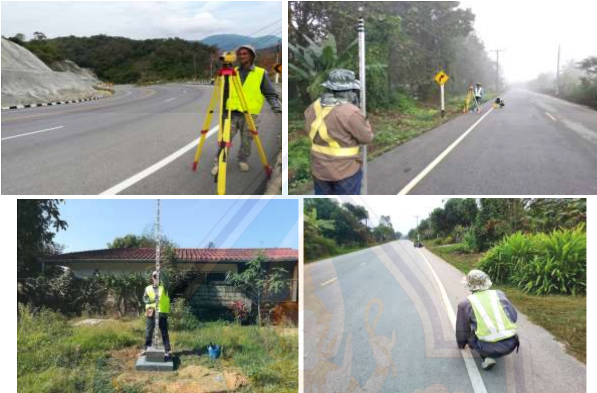
รูปที่ 3-11 การปฏิบัติทำงานระดับในพื้นที่โครงการ
